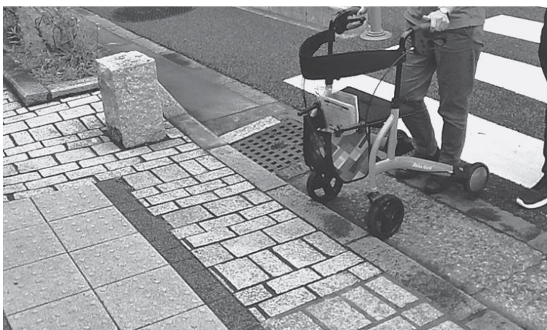
電動歩行器で横断歩道を渡った時に越えられない3 cmの段差
